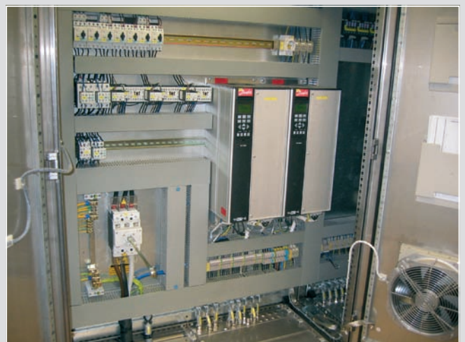
▶ Leistungsschrank mit Frequenzumformer
